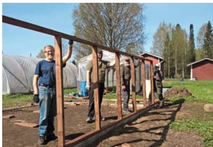
Kasvihuoneen rakentaja Lintulassa toukokuu 2016.
